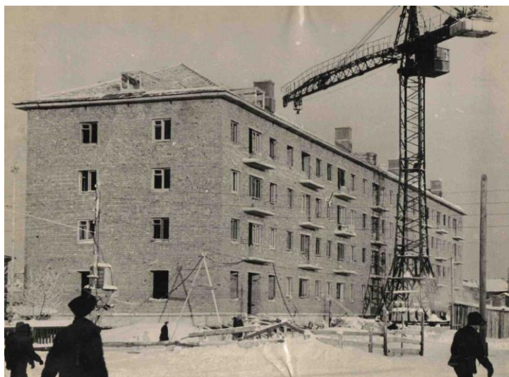
Строительство 64-квартирного дома по улице Речников. 1963 г.
