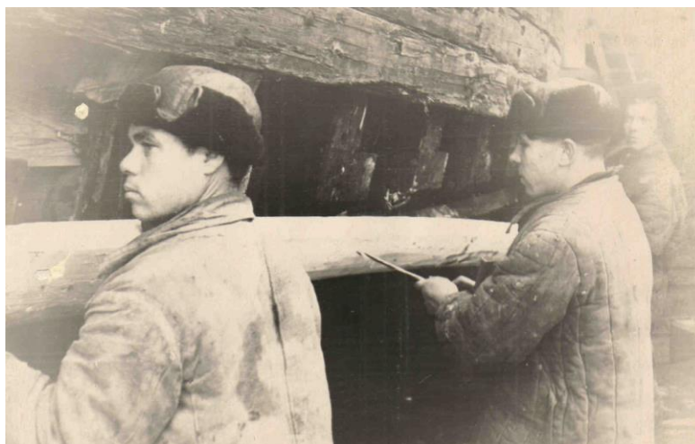
Ремонт корпуса деревянной баржи
