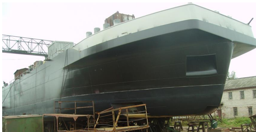
Строительство корпуса танкера BANZYSTAD для голландской фирмы RENSEN SHIPBUILDING BV. Сентябрь 2009 г.
